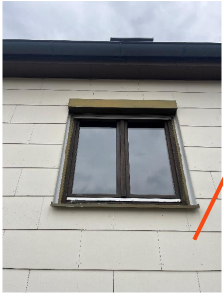
Fassade mit Holzfaserplatten & Holzfenster von 1960
