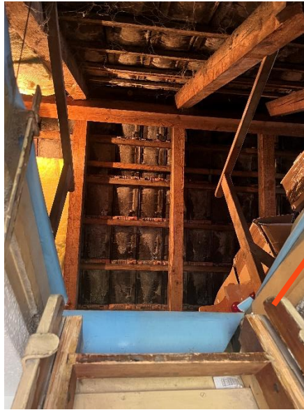
Ungedämmtes Dach
